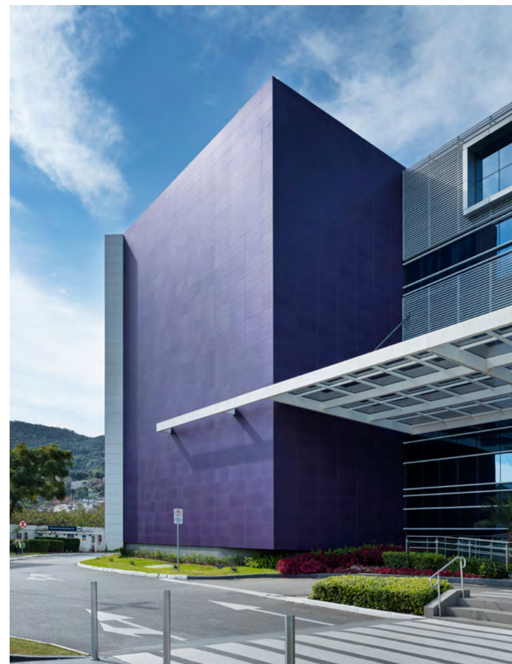
Floripa Shopping Florianópolis - SC Fachada Ventilada Ártico Alpe AC 60x120 cm, Porcelanato personalizado verde AC 60x120 cm e Porcelanato personalizado roxo AC 60x120 cm / 3.700m 2 Voss Engenharia
