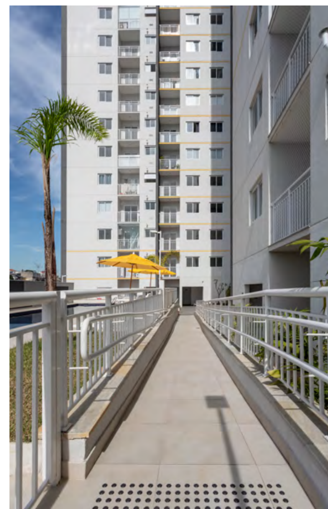
Moov Freguesia São Paulo - SP Produtos: Paredes internas, pisos internos e externos. Projeto Construtora Gafisa
